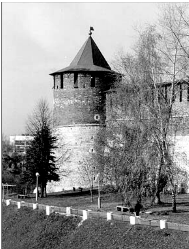
Коромыслова башня. Современный вид.
